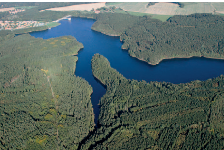
Římov Reservoir, Czech Republic. / Vodní nádrž Římov. / Foto P. Znachor.
